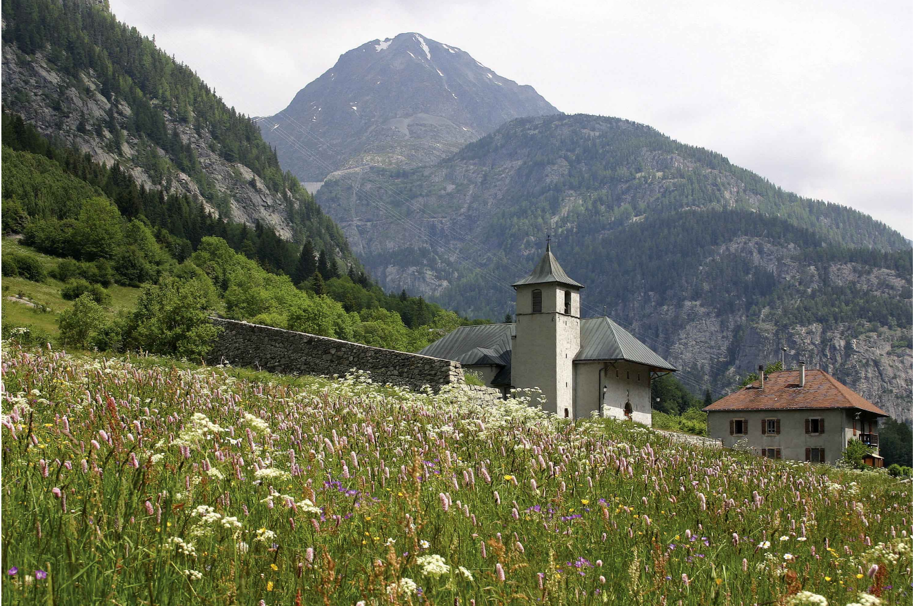
Figure 1. L'église de Vallorcine (France) et son presbytère, protégés par une « tourne » (étrave en maçonnerie), dont la construction a commencé en 1674. Elle a été renforcée et rénovée en 1720, 1843, 1861, et 2006.
