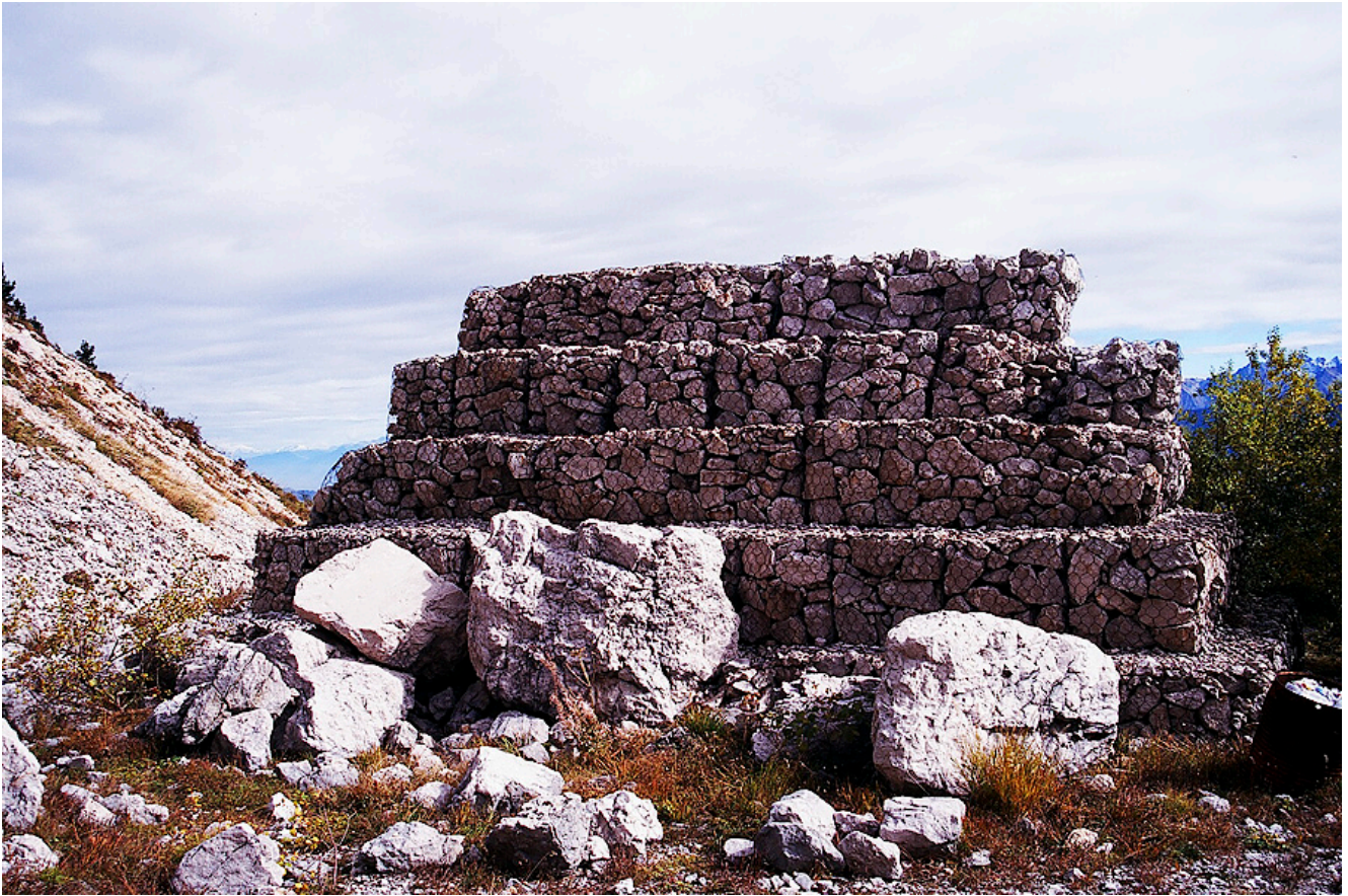
Photographie 5. Étrave en gabions sous les Rochers du Midi en octobre 1998. Source : Christophe Ancey.
