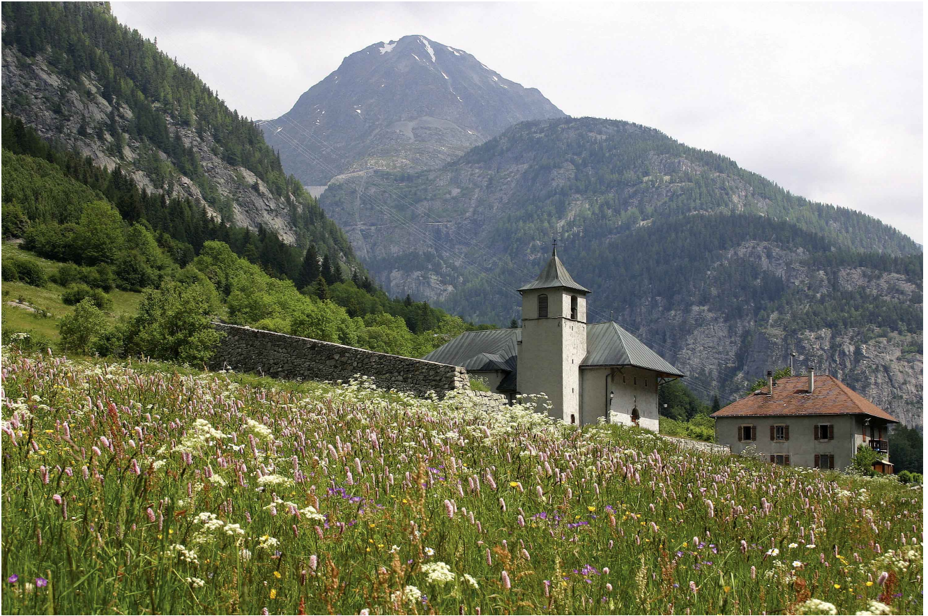
Figure 1. L'église de Vallorcine (France) et son presbytère, protégés par une « tourne » (étrave en maçonnerie), dont la construction a commencé en 1674. Elle a été renforcée et rénovée en 1720, 1843, 1861, et 2006.
